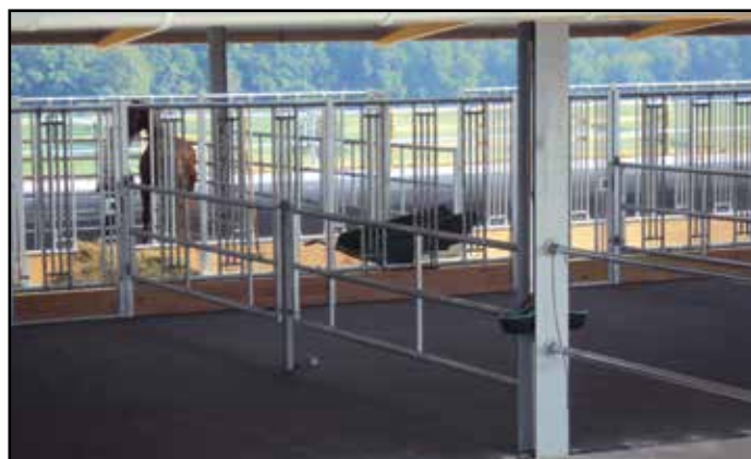
Buchtenabtrennungen aus Teleskoptüren
