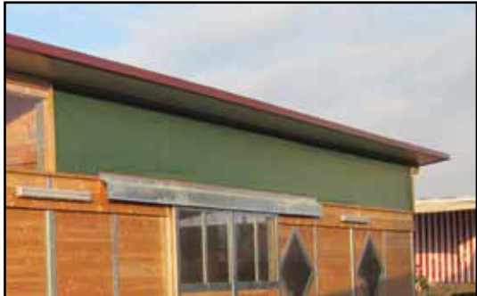
Windnetz-Rollenware - Befestigung mit Holzleisten (bauseits), keine Befestigungsösen enthalten.
