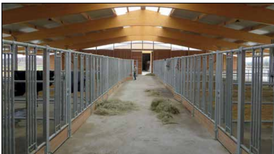
Laufställe mit Sicherheits-Durchfressgitter und Teleskopabtrennungen
