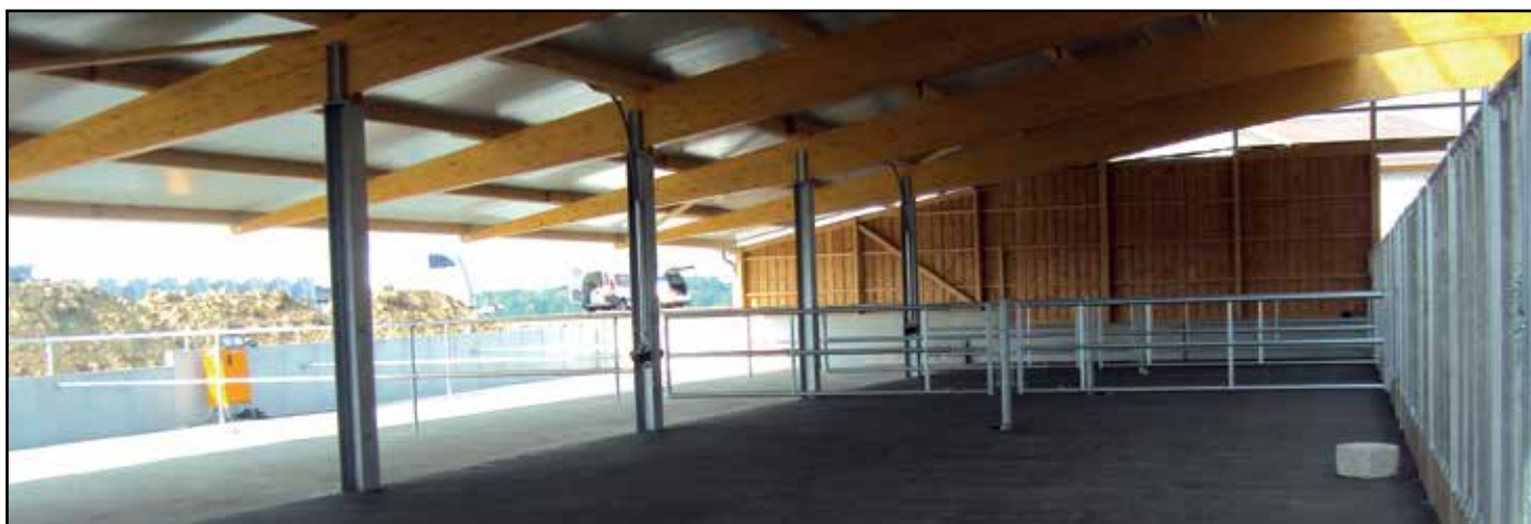
Laufstall mit großem Liegebereich und Buchtenabtrennungen aus Teleskoptüren
