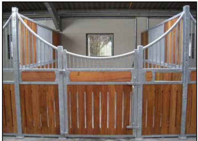
Pferdeboxen „Oxford Exklusiv“ mit Denya-Hartholz und Lüftungsschlitzen
