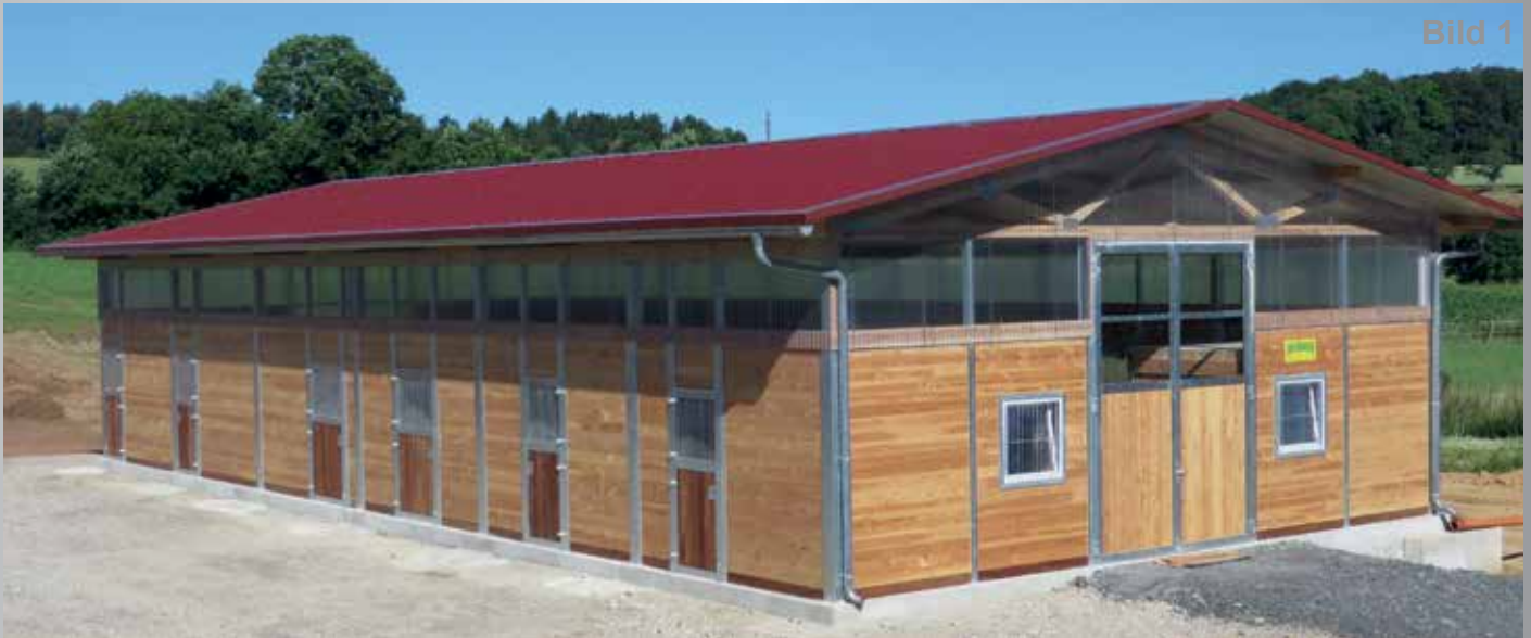
Freitragender Stall mit Nagelbindern
