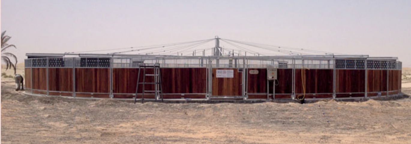
Boden-Führanlage mit Umzäunung, Abu-Dhabi
