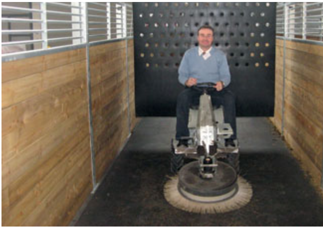
Kombination Gummiboden und aufrollbare Trenngitter machen eine maschinelle Reinigung möglich
