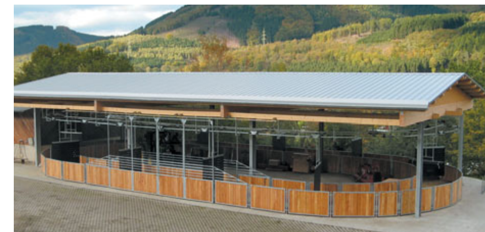
Gleitschienen-Führanlage kombiniert mit Maschinenhalle, RZV Plettenberg im Sauerland
