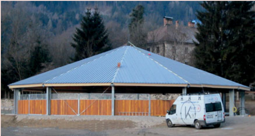
Decken-Führanlage, Glock Performance Center, Treffen, Österreich
