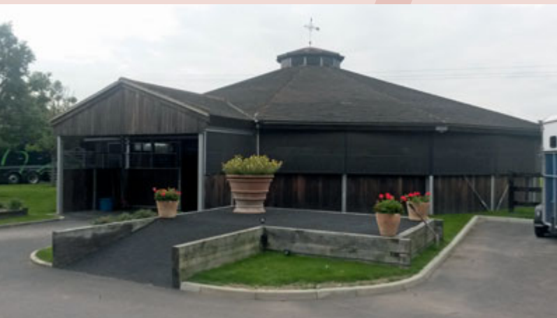
Decken-Führanlage, Hampshire Equine Clinic, Großbritannien
