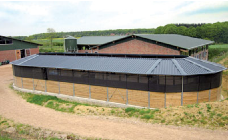
Reitanlage Rosengarten, Wendt, 10×26m, 9 Pferde
