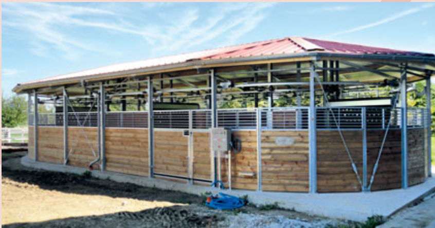
Gleitschienen-Führanlage mit Komplett-überdachung und aufrollbaren Trenngittern, Lenherr Sportpferde, Pfyn, Schweiz
