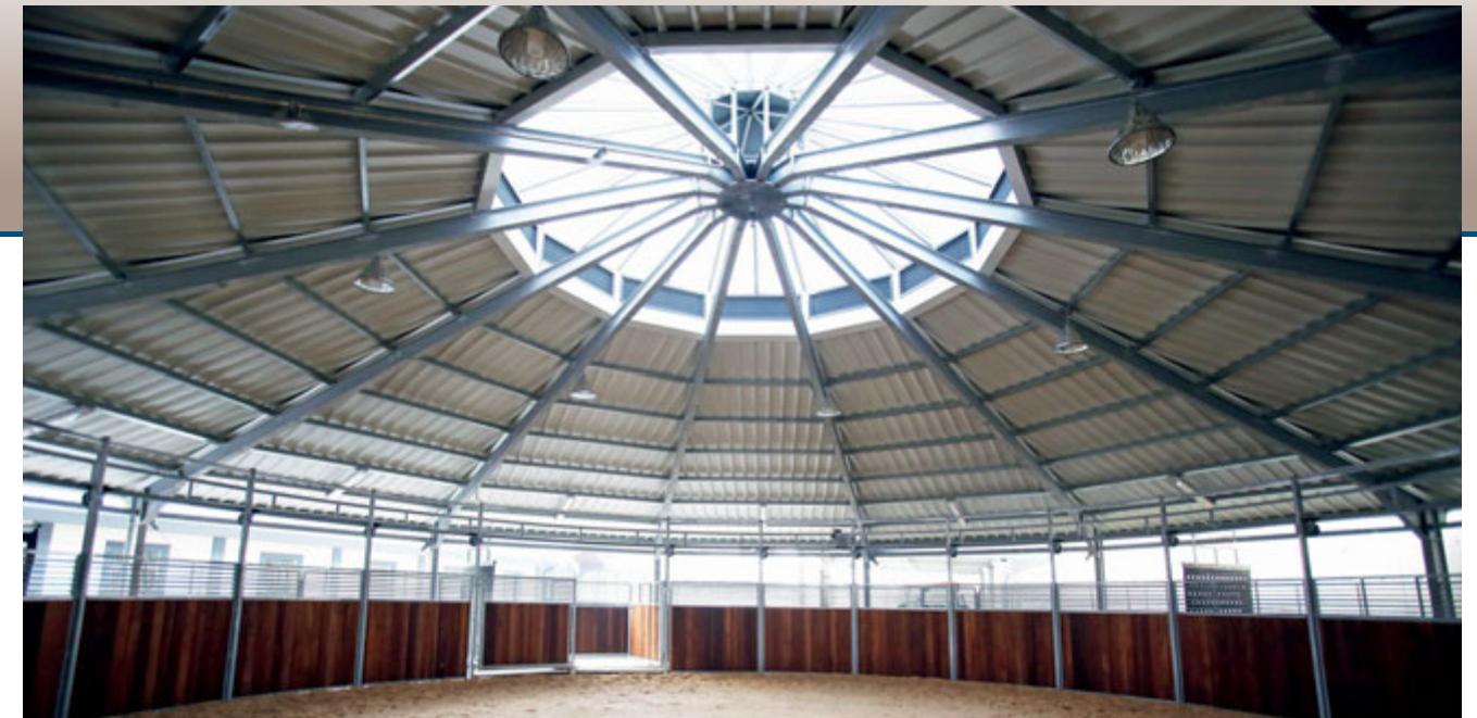
Blick in den freien Innenraum
