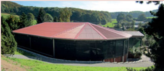
Gleitschienen-Führanlage mit Komplettüberdachung, Volkmann, Sainerhof, Ötzingen, Deutschland
