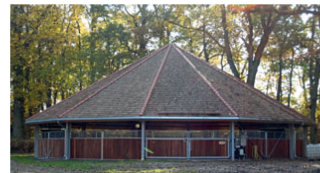
Dacheindeckung mit Ziegeln
