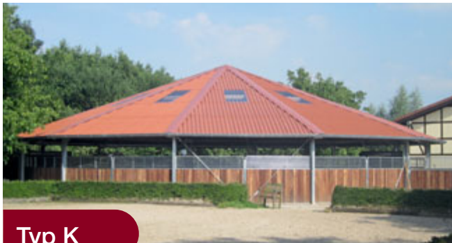
Typ K senkrechte Hartholz-Bohlen, 40 mm, gehobelt, Nut und Feder geschlossen bis 1,5m, mit verzinktem Aufsatzrahmen von 1,5–2,0 m mit Querrohren oder Schweißgittern mit Zwischenpfosten für 24-Eck
