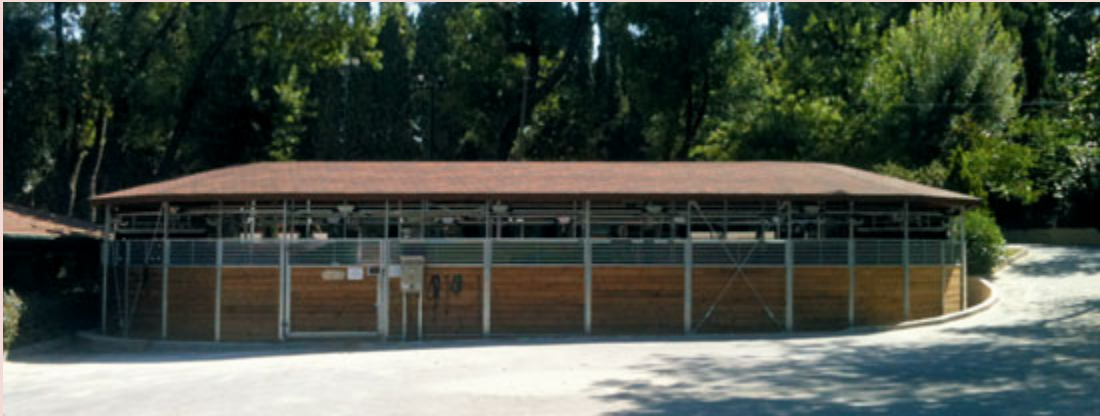
Gleitschienen-Führanlage, IASK Istanbul, Türkei
