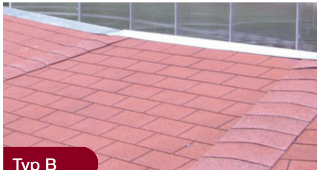
Typ B Bitumen-Schindeln inklusive Unterbahn und Abschalung
